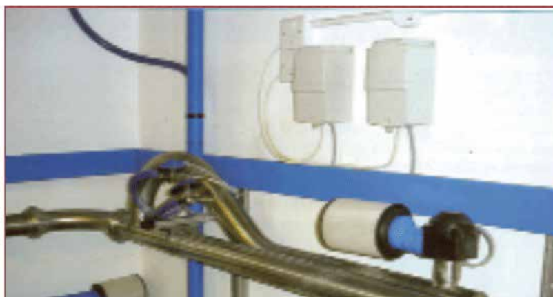
Figura 9. Instalación de un inyector de aire
