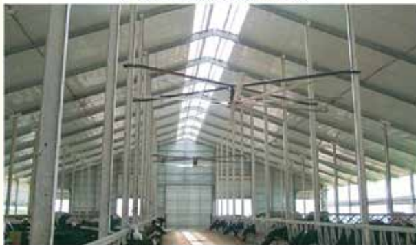
Figura 3. Ventiladores HVLS incorrectamente colocado sobre un pasillo de distribución de alimento.
