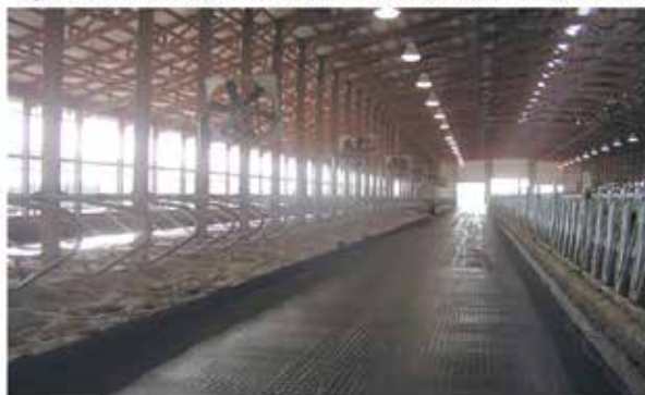
Figura 1. Ventiladores de circulación colocados sobre los cubículos.
